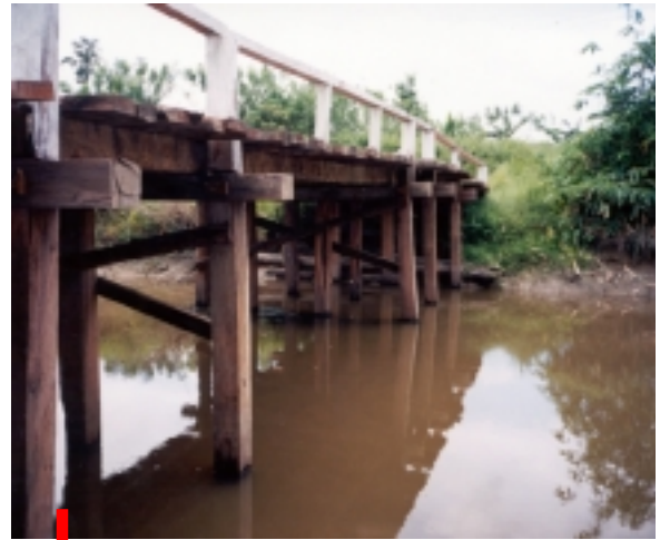
Prioritas utama pembangunan: prasarana dan sarana yang bermanfaat bagi masyarakat luas
