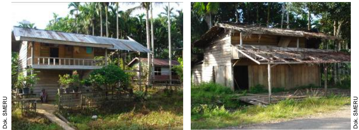
Gambar 6. Rumah yang tergolong baik (kiri) dan yang ditinggal mengungsi (kanan)
