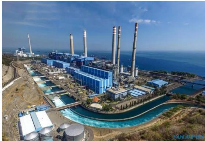
SOLOPOS.COM - Kompleks PLTU Palton di Kabupaten Probolinggo dan Situbondo, Jawa Timur. (Antara/Dokumentasi PT Pembangkitan Jawa-Bali)
