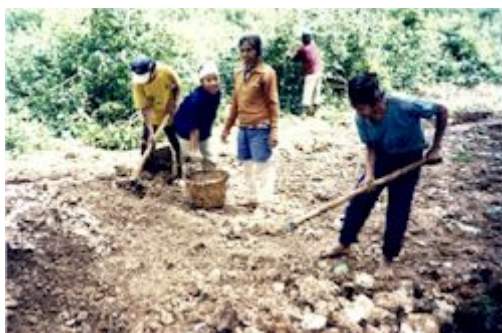
Men and women working on simple village road, Kabupaten Muna, Southeast Sulawesi Laki-laki dan wanita bekerja pada pembangunan jalan desa sederhana, di Kabupaten Muna, Sulawesi Tenggara
