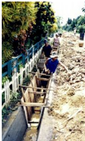
Constructing simple concrete drains, Kabupaten Kendari, Southeast Sulawesi Membangun selokan sederhana, di Kabupaten Kendari, Sulawesi Tenggara
